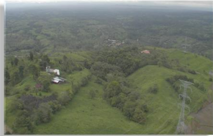
RECONSTRUCCION LINEA DE TRANSMISIÓN TRAPICHE – LEESVILLE (SIQUERRES – POCOCI) Proyecto de Transmisión de las regiones Huétar y Brunca
